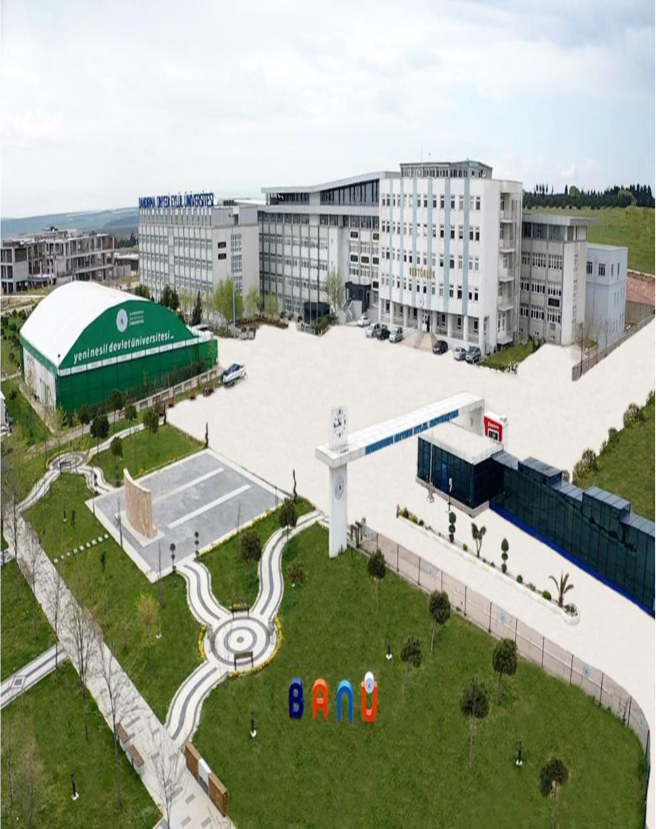
Resim 1- Rektörlük Merkez Yerleşkesi
